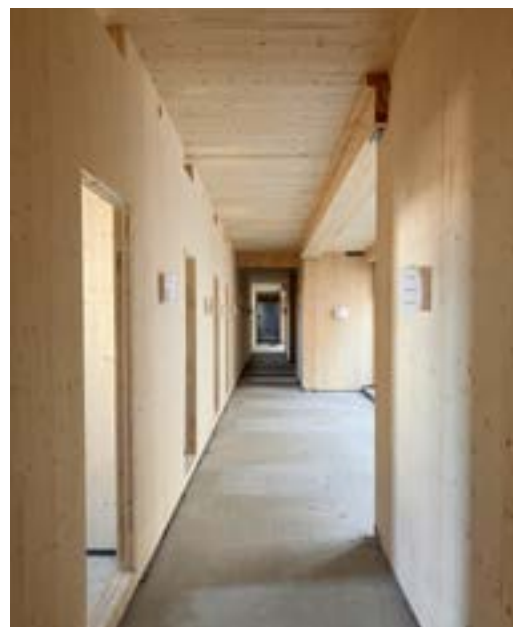
Abb. 9: Holzrohbaus aus Massivholzelementen
