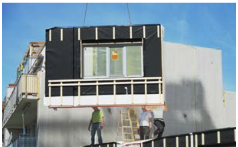
Abb. 11: Montage als Voraussetzung
