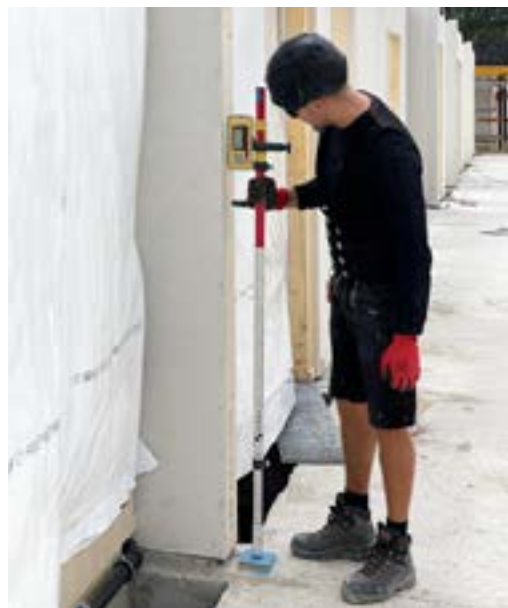
Abb. 31: Kontrolle von Toleranzen im Baufortschritt
